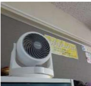
各教室に2台ずつ首振り式のサーキュレーターを設置し、換気の効率化と室内の温度を保つ工夫をしています。
